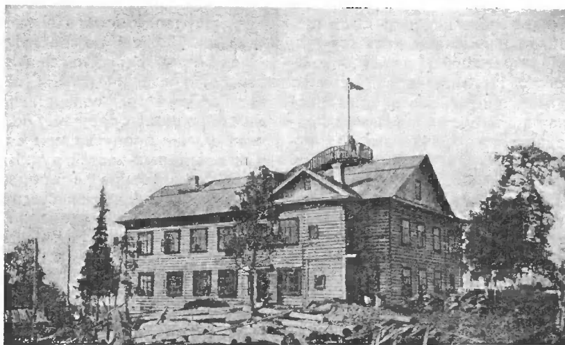
Новое здание Беломорской станции Гос. Гидрологического института в губе Малая Пирью.
